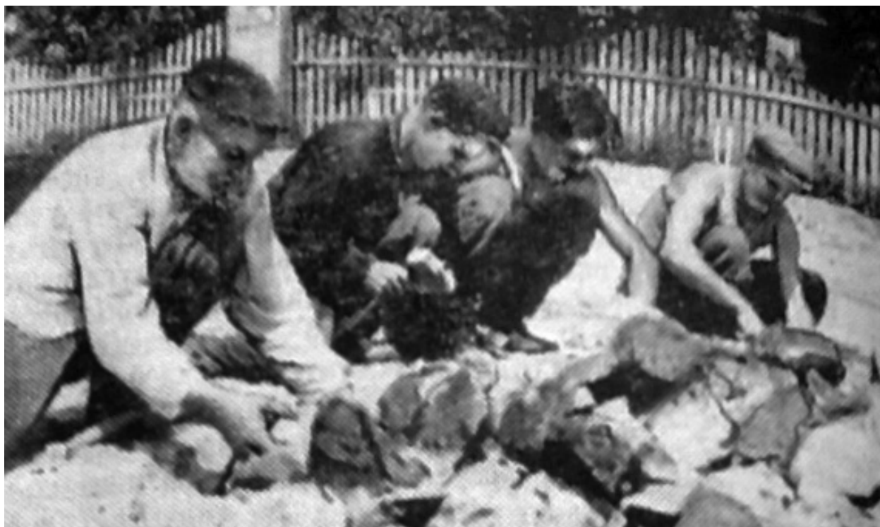
Прокладка мостовой на улицах Староверовки, 1959 г.
